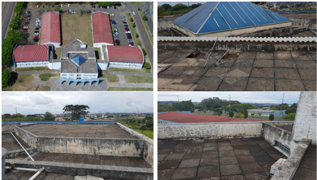
Figura 2 - Sistema de piso elevado da Reitoria
