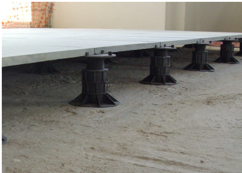
Figura 1 - Exemplo de laje exposta com sistema de piso elevado
