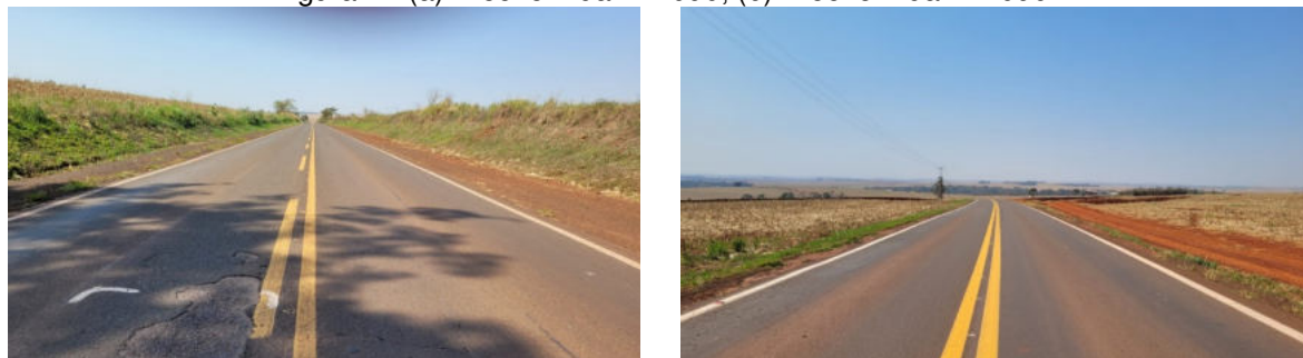
Figura 2 - (a) Trecho 1 da PR-090; (b) Trecho 2 da PR-090
