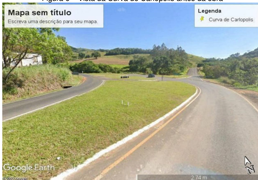
Figura 6 – Vista da Curva de Carlópolis antes da obra
