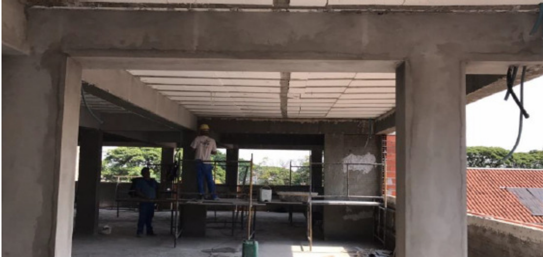
Figura 7 – Serviço em altura realizado em ambiente interno
