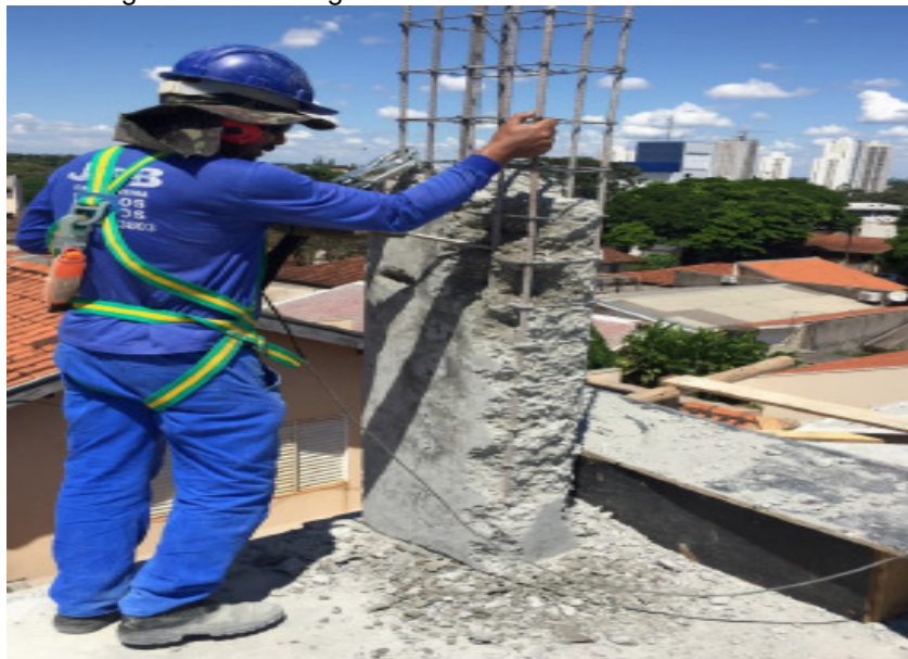
Figura 8 – Ancoragem em trabalhos realizados em altura
