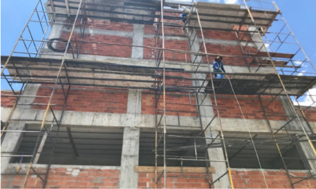
Figura 6 – Serviço em altura
