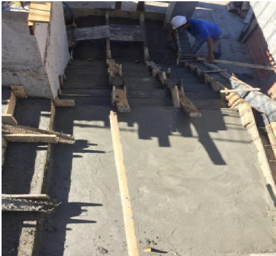
Figura 3 – Escada do terceiro pavimento
