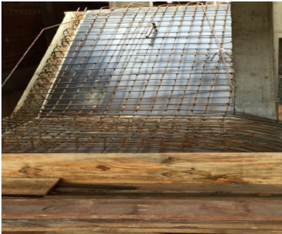
Figura 2 – Estrutura da escada do primeiro pavimento
